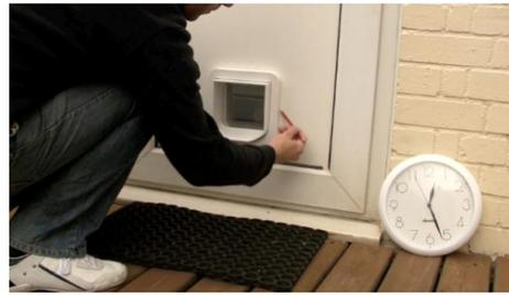
Ein größeres Loch und damit mehr Abstand (2-3 cm) zwischen Metal und SureFlap ist nötig. Als Richtlinie sollte der Außenrahmen genutzt werden.
