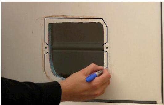
Bitte die Linie nachziehen und diese dann dementsprechend ausschneiden. Die Löcher für die Schrauben aussparen, wie hier gezeigt.
