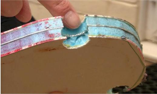
Bei Einbau der Katzenklappe kann festgestellt werden, dass Metall in der Tür vorhanden ist. Dies kann zu Beeinträchtigung der SureFlap Leistung führen. Bitte Anleitung im Handbuch ab Seite 34 (6.3) folgen.
