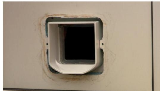
Das Loch sollte nun so aussehen. Die Installation kann nun wiederholt werden, mit den Vorhandenden Löchern für die Schrauben.
