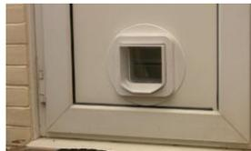
Der fertige Einbau wird so aussehen, wo bei der Montageadapter das benötigte größere Loch abdeckt. Bitte den Adapter auf der anderen Seite noch mit Silikon befestigen.
