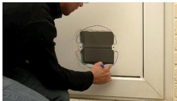
Dann mit einem Abstand von 2cm zum äußeren Ring einen weiteren Ring (innen) zeichnen und auch hier die Löcher für die Schrauben so lassen, wie sie sind.
